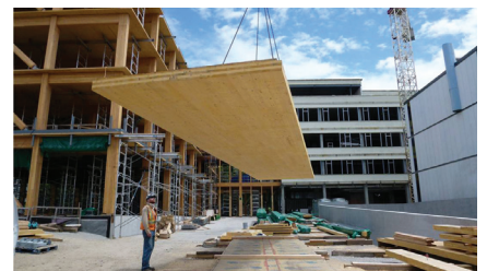
공사 중의 지구과학관 (사진 출처: naturallywood.com)
